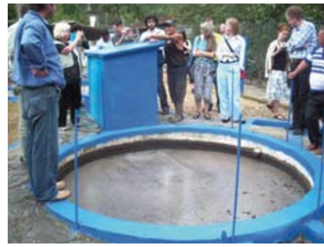
Småskalig biogasanläggning ger gas till köket och svetsen ur grisgödsel.
