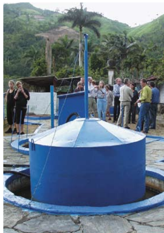
Småskalig biogasanläggning ger gas till köket och svetsen ur grisgödsel.
